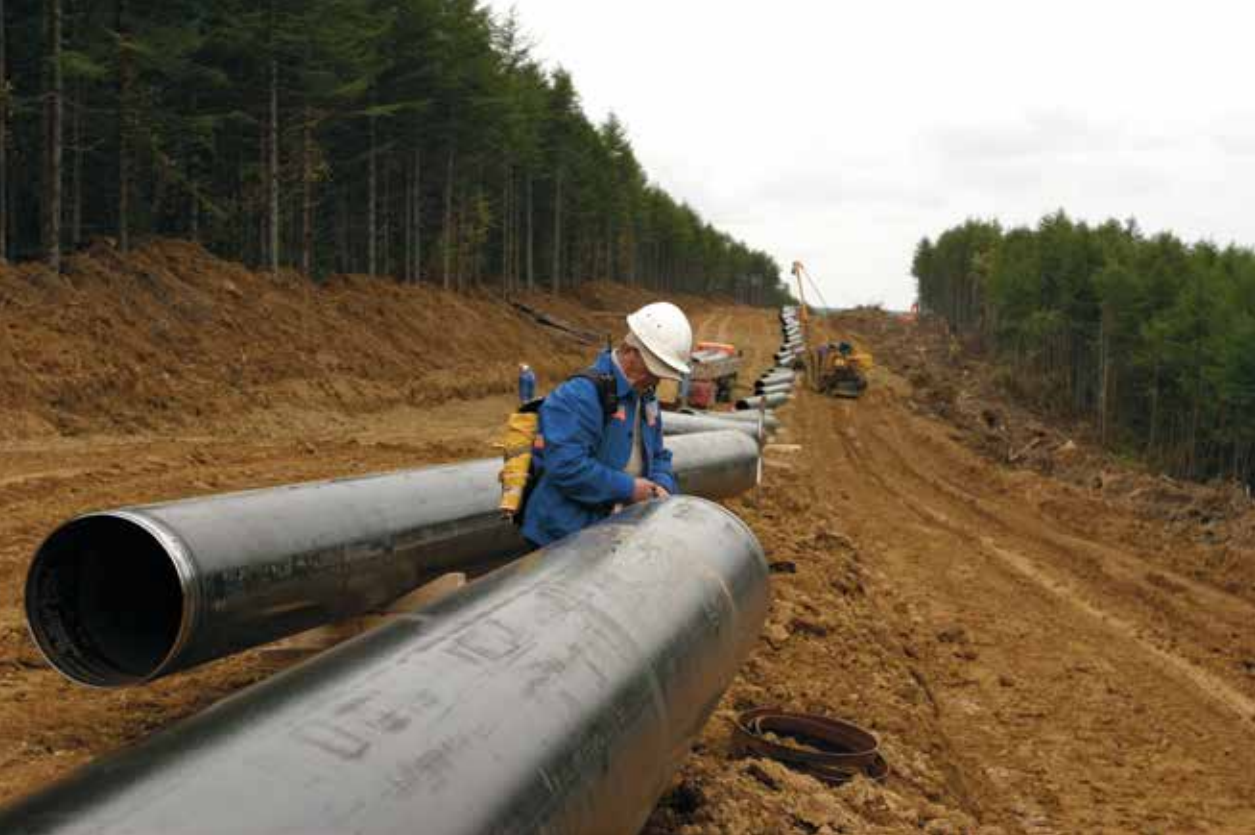
Travaux de construction d'un pipeline pour une usine à gaz et un terminal pétrolier en Russie (© Peter Blakely – Redux/laif)
