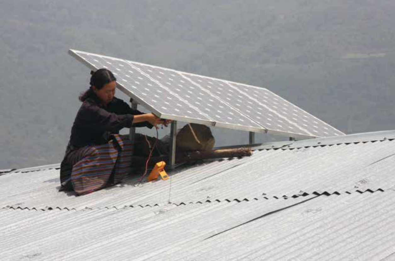
Une femme installe des panneaux solaires sur la toiture au Bhoutan. (CC BY-NC-ND 2.0 Banque asiatique de développement – flickr)
